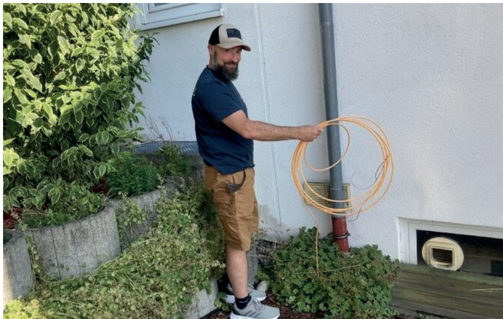
Andrew Berkshire an der Stelle, wo Monate nach dem Fototermin die erlösende Muffe in Rollis Garten verlegt wurde. Neben der Katzenklappe ist der Anschluss verlegt worden. © Sebastian Striebich
